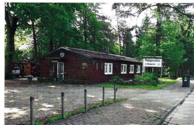
Bauleitung (Führer Mühlweg)
