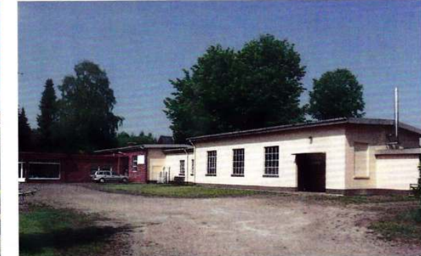
Fertigstellung (Liegnitzer Straße)
