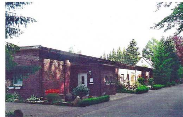
Fertigstellung (Thorner Straße)
